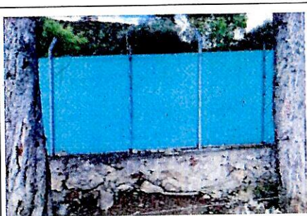
M1. Cerramiento Frontal en malla
