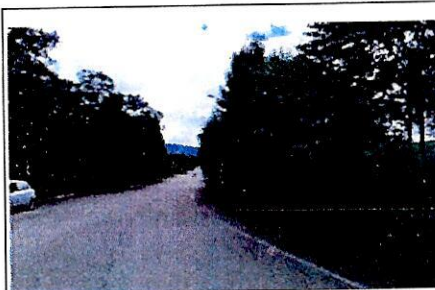
M2. Vía Pavimentada
