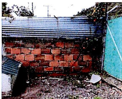
M6. Muro Lindero Norte
