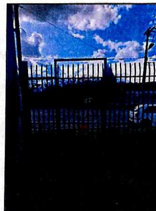
M9 – PUERTA METÁLICA
