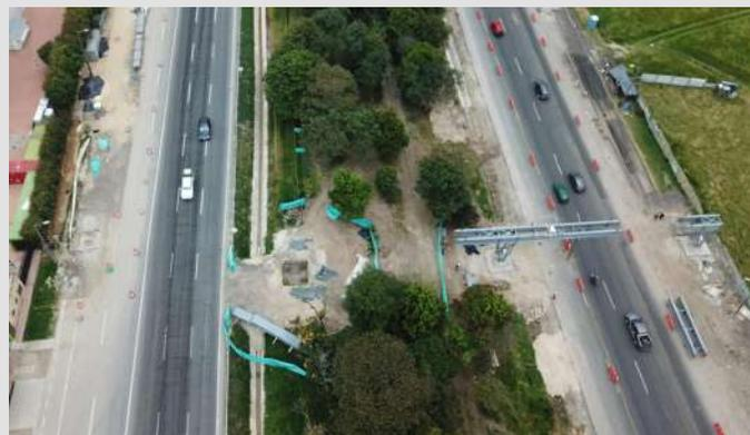
El desarrollo de este puente peatonal se da en 92m de longitud aproximadamente con 7m de altura con dos rampas, en las cuales se proyectan tres tramos de longitud aproximada de 23m con pendientes máximas del 10% y descansos de 1.5m de longitud.
