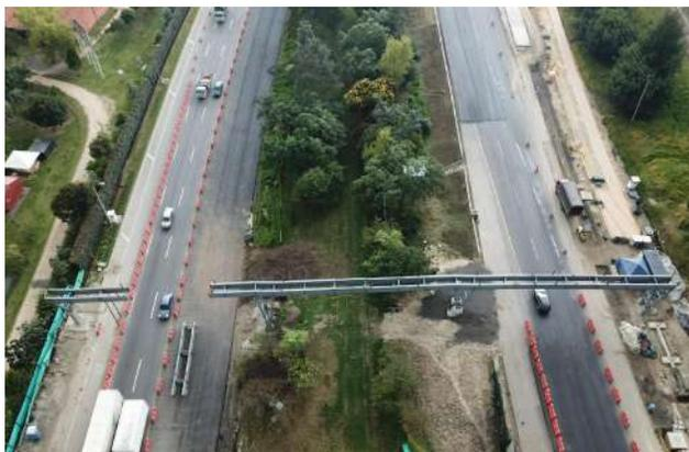
Este puente peatonal tiene una longitud aproximada de 92m de desarrollo, su altura varía entre 7 y 8 metros debido a la diferencia de niveles entre calzadas garantizando el gálibo mínimo exigido de 5.65m; sus rampas se desarrollan en tres tramos en el costado oriental y cuatro tramos en el costado occidental con pendientes máximas del 10% y descansos de 1.5m de longitud.
