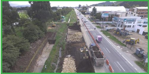
El pasado 5 de junio de 2018, AceNorte S.A.S, dio inicio a la ampliación de la calzada oriental de la vía, realizando labores de excavación y relleno con pedraplén,
