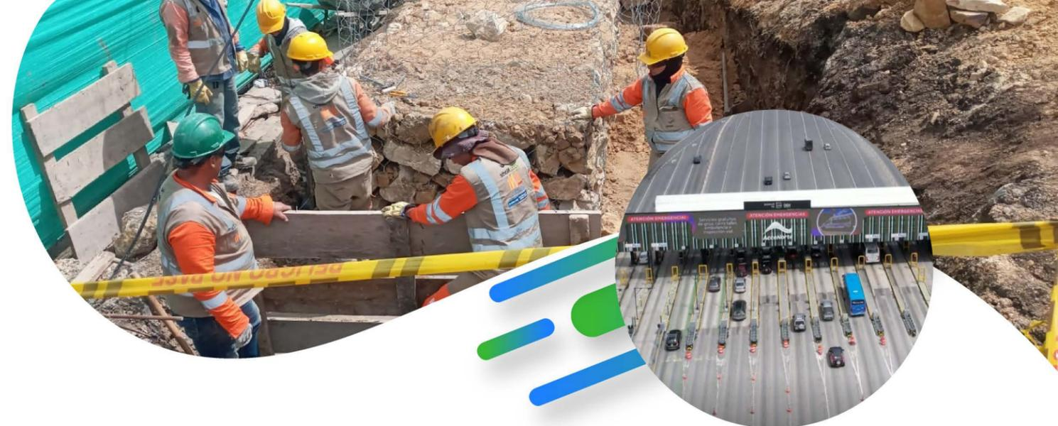
AcceNorte S.A.S. ha adelantado trabajos de intervención de la estructura de la vía (Ampliación) sobre todo el corredor vial de la Carrera Séptima; dichas actividades corresponden al proceso constructivo de explanaciones, conformación de las capas de granulares y adecuación del material para la extensión y compactación de Base Asfáltica.
